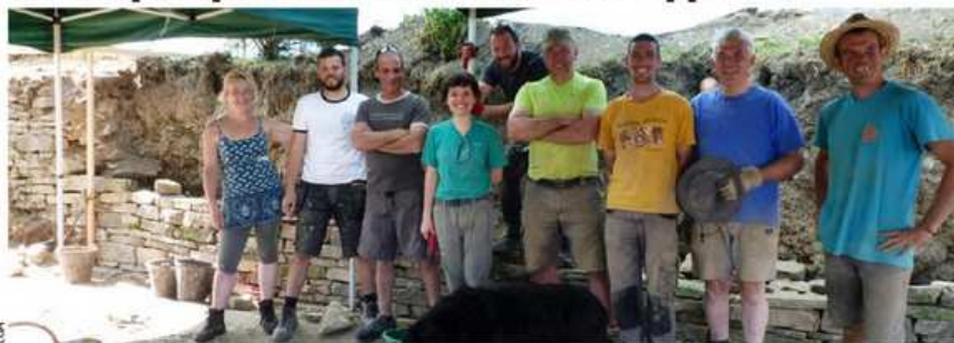
À Hubermont, dans la commune de La Roche-en-Ardenne, un chantier-formation vient de se terminer. Ce chantier s'inscrivait dans projet Interreg « Pierre sèche en Grande Région »
