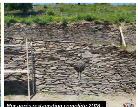
Mur après restauration complète 2018.
