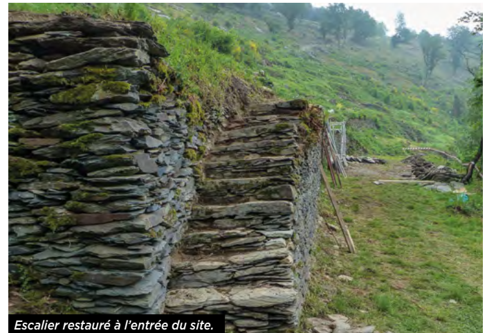
Escalier restauré à l'entrée du site.
